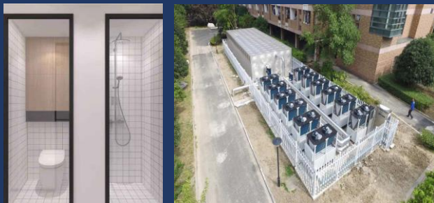
【热水洗浴】集中式空气源热泵
